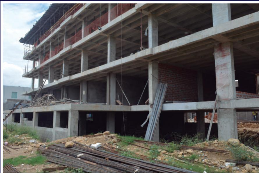
Desde la vista lateral del edificio Cantagiron se puede observar con mayor claridad la distribución de los espacios por cada piso, las columnas y placas fundidas hasta la fecha.
